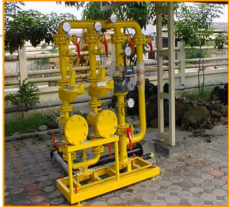
Equipos de regulación y medición montados en un “skid” para aplicaciones industriales o comerciales con consumos importantes
