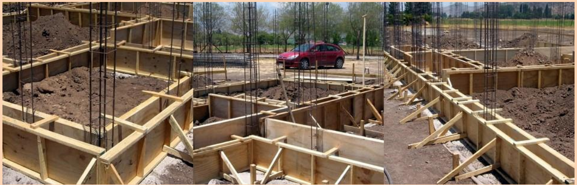
Diferentes vistas de encofrado de Sobrecimientos
